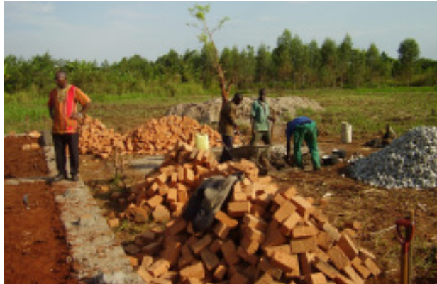
Der Bau des Schulgebäudes in Bwacapira-Kooki in Uganda schreitet voran
