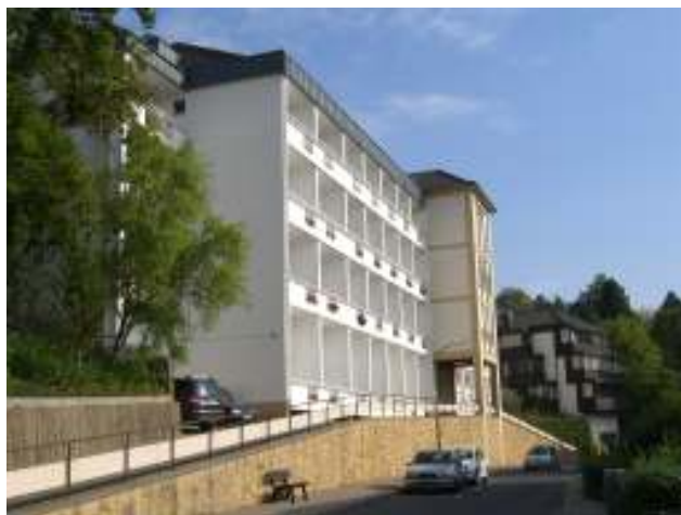
Josefsheim mit Anbau im September 2006
