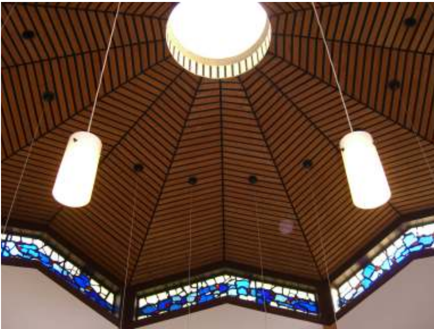
Ein Blick zum Dach der Kapelle
